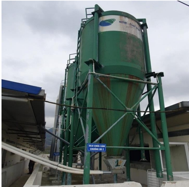
Hình 1.4: Hệ thống silo cám cung cấp thức ăn tự động cho lợn (Ảnh minh họa)
