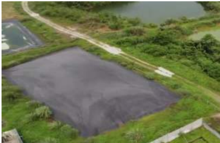
Hầm Biogas tại Trang trại
