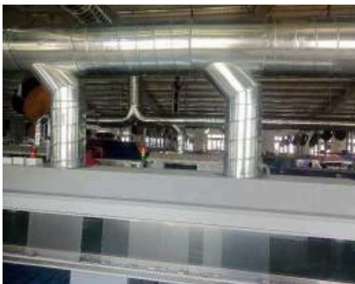
Hình 3.7. Hệ thống xử lý khí thải tại khu vực in, dán keo
