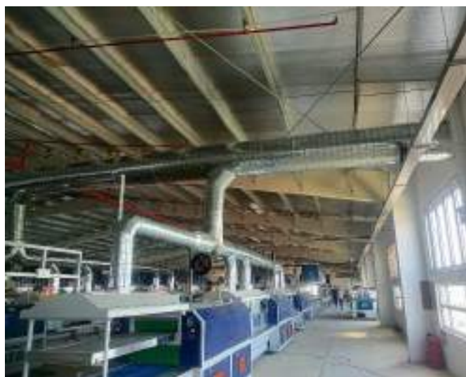
Hình 3.7. Hệ thống xử lý khí thải tại khu vực in, dán keo
