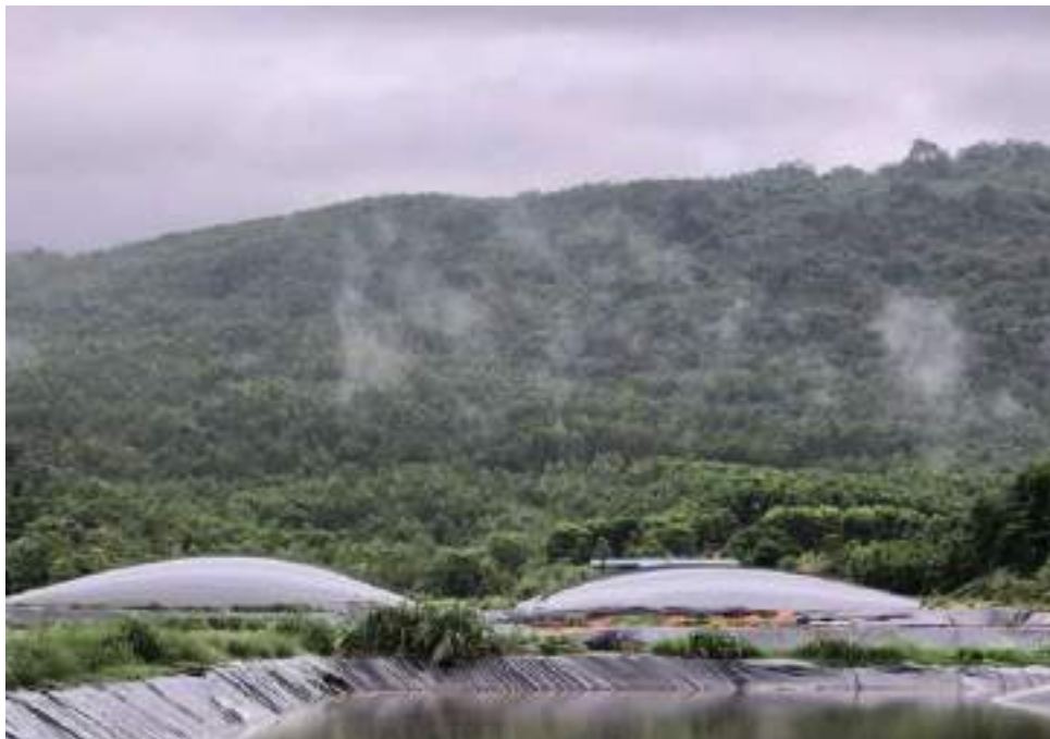
Hình 3.6. Hầm Biogas của trang trại
