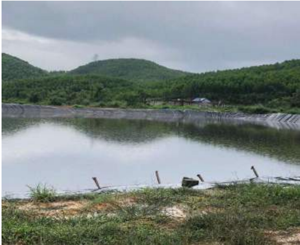
Hình 3.7. Hầm sơ lắng của trang trại
