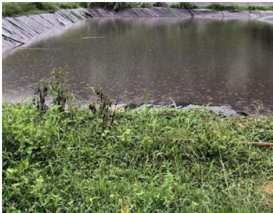
Hình 3.8. Hầm điều hoà của trang trại
