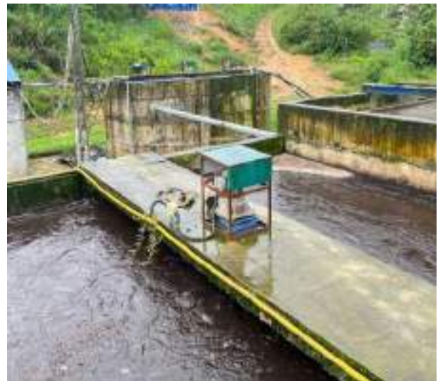
Hình 3.10. Hình ảnh Trạm xử lý nước thải 400 m 3 /ngày đêm.
