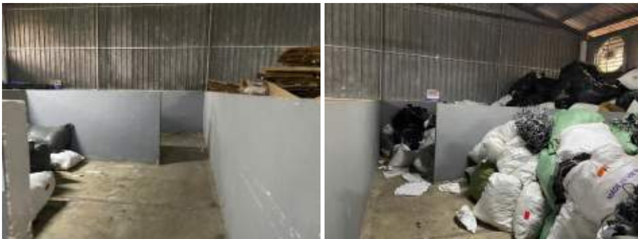
Hình 14: Hình ảnh hiện trạng công trình khu vực lưu chứa chất thải công nghiệp
