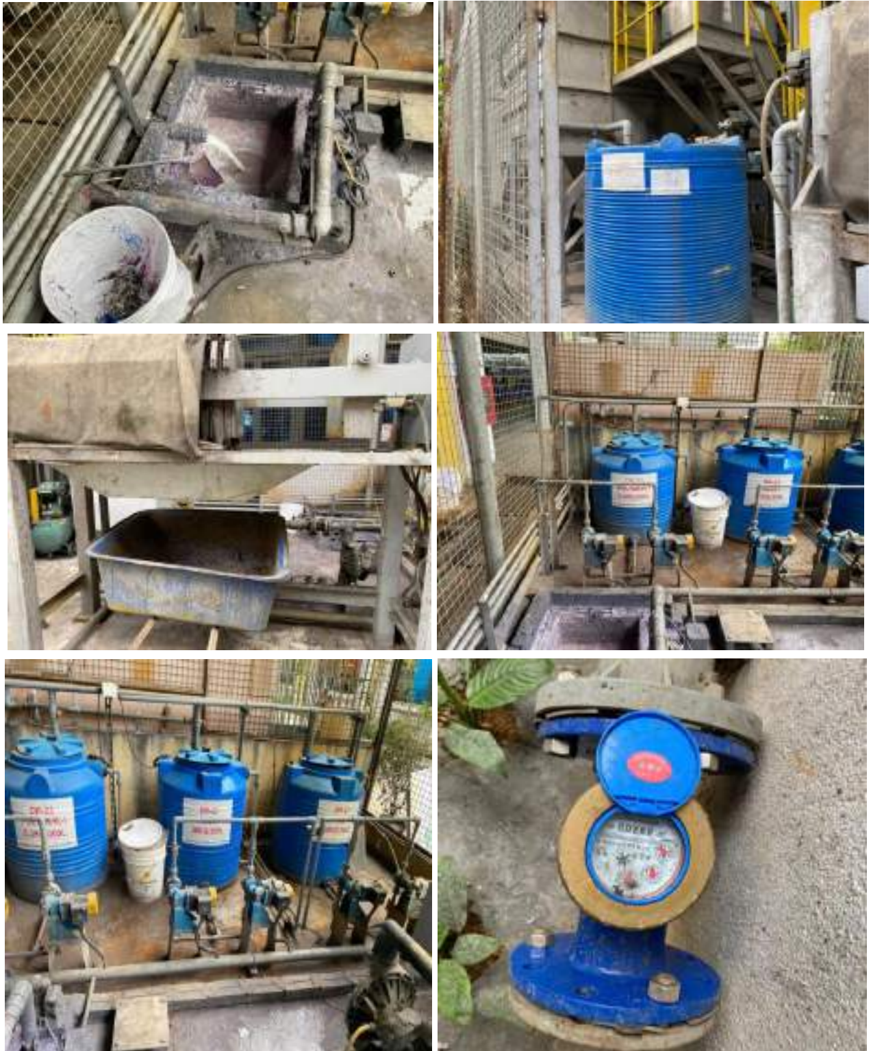
Hình 6: Hình ảnh hiện trạng công trình xử lý nước thải sản xuất của cơ sở
